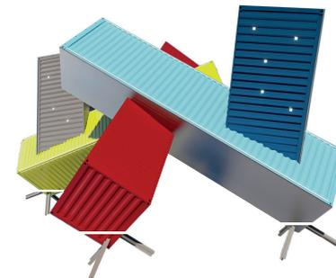
3 angles des conteneurs de 40 pieds sont enfouis dans le sol d'où plongent des poutres en acier qui vont s'ancrer dans des dés en béton.
