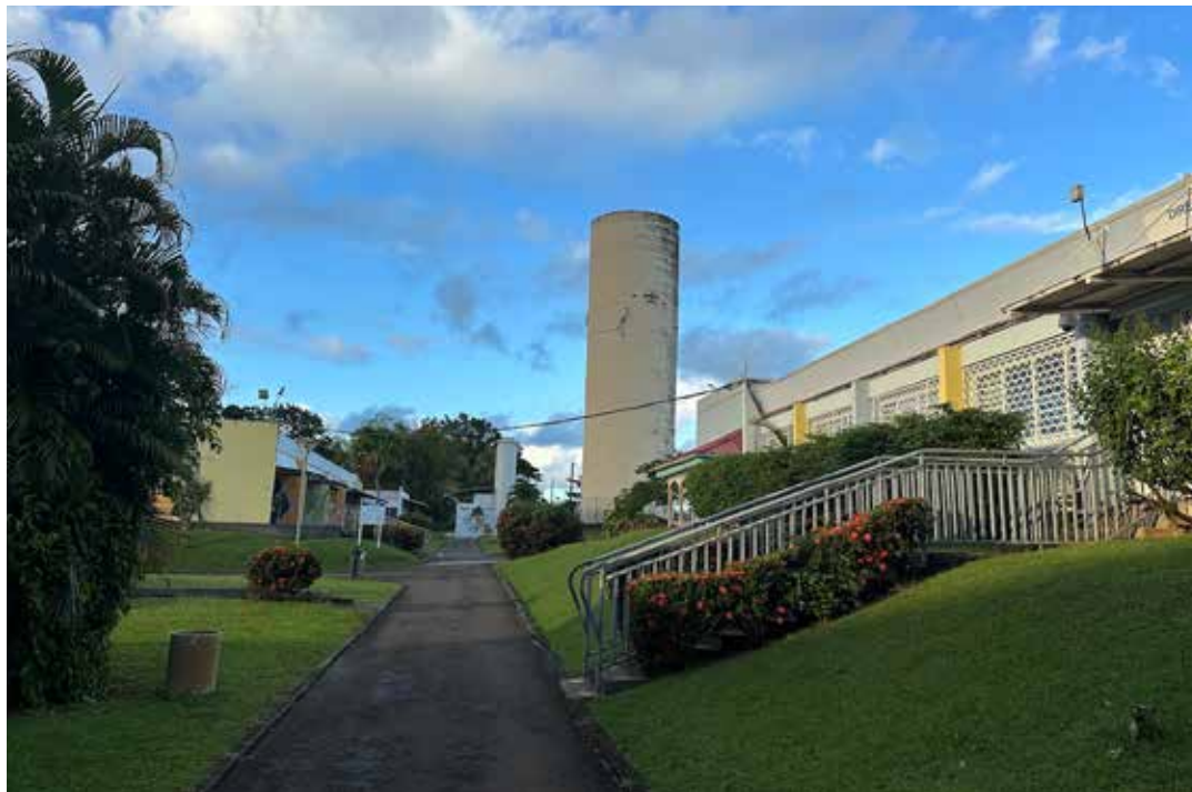
1 Vue du collège Petit Manoir, la façade sud du château d'eau.
