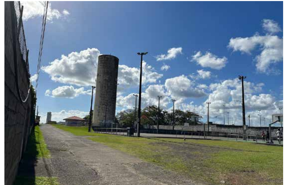
2 Depuis l'entrée du plateau sportif sur l'avenue Frantz Fanon.
