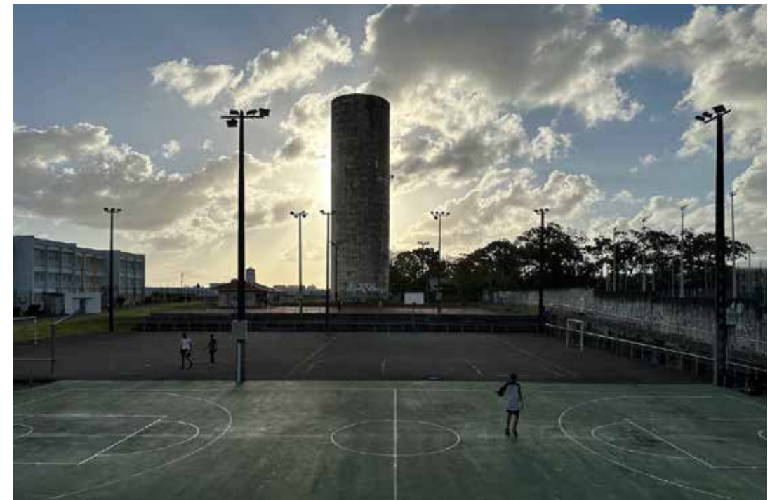
3 Façade est de l'édifice, dans l'axe du plateau sportif.
