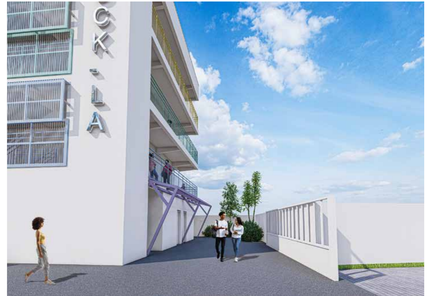
Façade Nord avec en RDC le passage vers la coursive Ouest et l'entrée des toilettes protégée par un auvent
