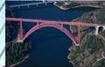
Pont en arc (Viaduc de Garabit, France)
