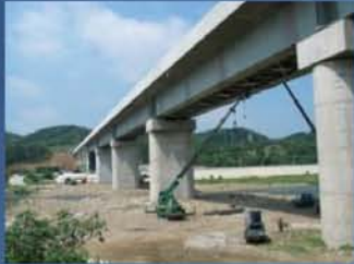
Pont à poutre (Pont LGV, Taiwan)
