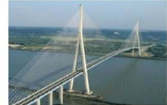
Pont à hauban (Pont de Normandie, France)
