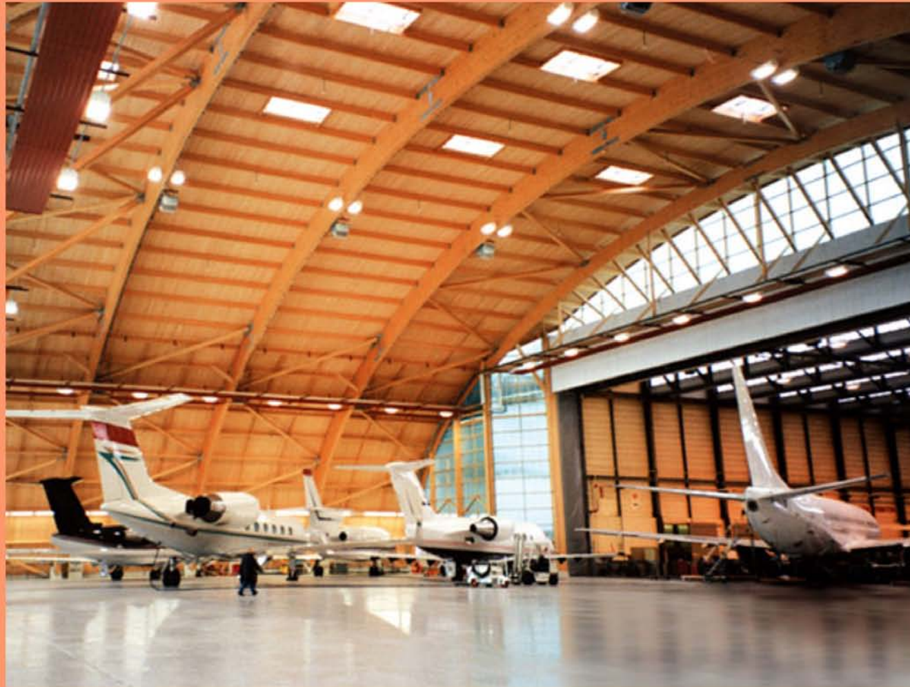
Hangar de l'aéroport Bâle-Mulhouse
