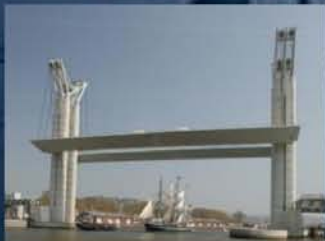
Pont levant (Pont Gustave Flaubert, France)
