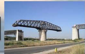
Pont tournant (Pont de Caronte, France)
