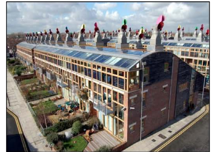
Eco-quartier de Bedzed, Angleterre
