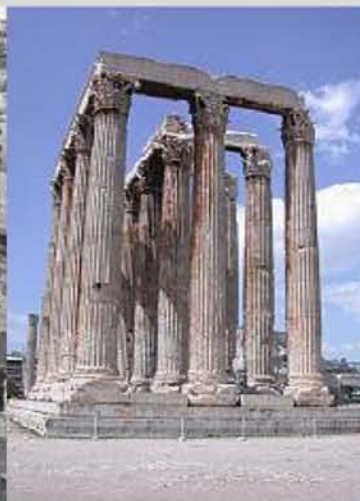
Construction romaine: L'Olympiön
