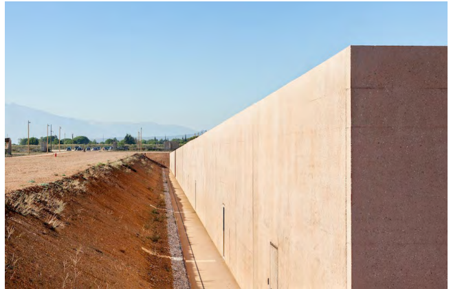
Mémorial du camp de Rivesaltes Salses-le-Château, France Rudy Ricciotti, Passelac & Roques Architectes
