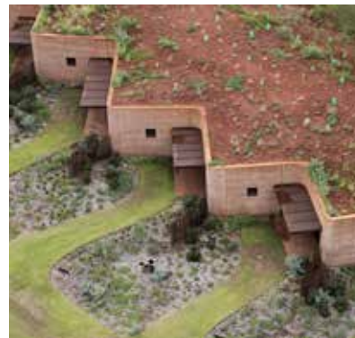
17 Habitat pour bergers dans le Pilbara, Australie
