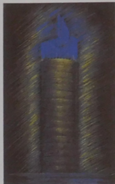
"eaux bleues" : illumination château d'eau Petit Manoir au Lamentin
